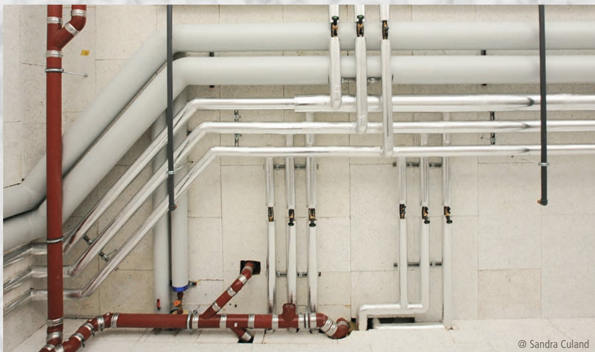
Condominio situato a Nyon – Impianto sanitario acqua calda-fredda coibentato con swissporKISODUR PIR Alu rinforzato
